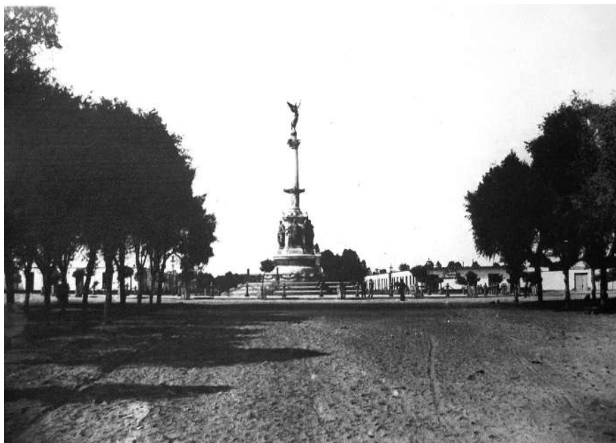
Figura 13. Fotografía del último tercio del XIX. Vista de norte a sur. Nótese la zona casi desolada y las dimensiones modestas de los inmuebles en comparación al monumento. Tomado de “Plazas y plazuelas”.
