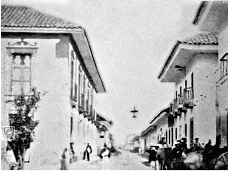
Figura 5. Panorámica de la calle del comercio de Buga, 1885
